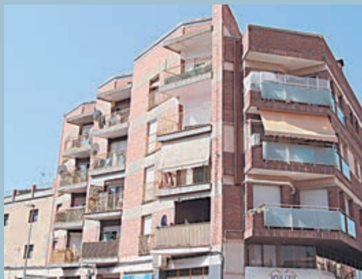
FOTO_L.M. Imatge d'un bloc de pisos a la ciutat de Mollerussa, a la comarca del Pla d'Urgell
