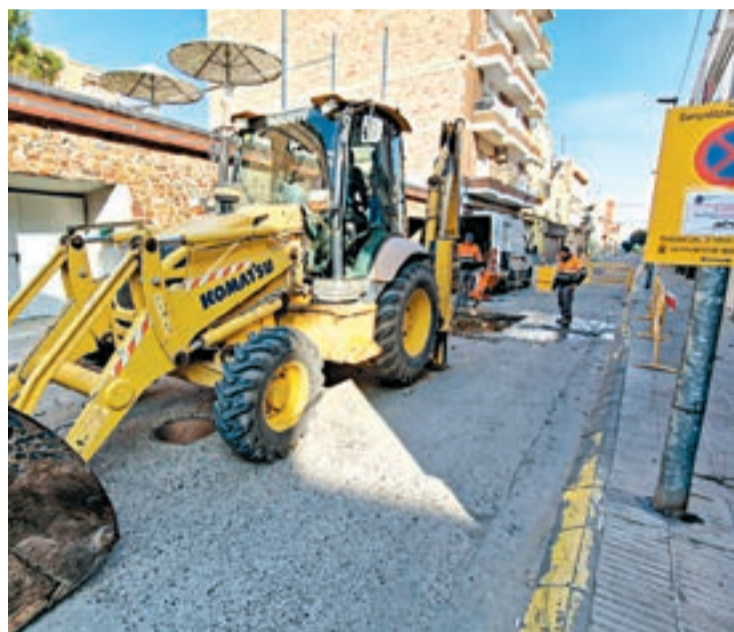
Aj.Mollerussa Obres al carrer Sant Isidori de Mollerussa
