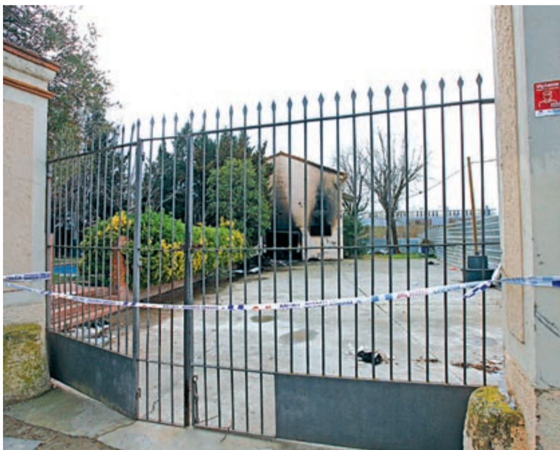
FOTO_ Tony Alcántara L'interior de la planta baixa de la casa va quedar calcinat
