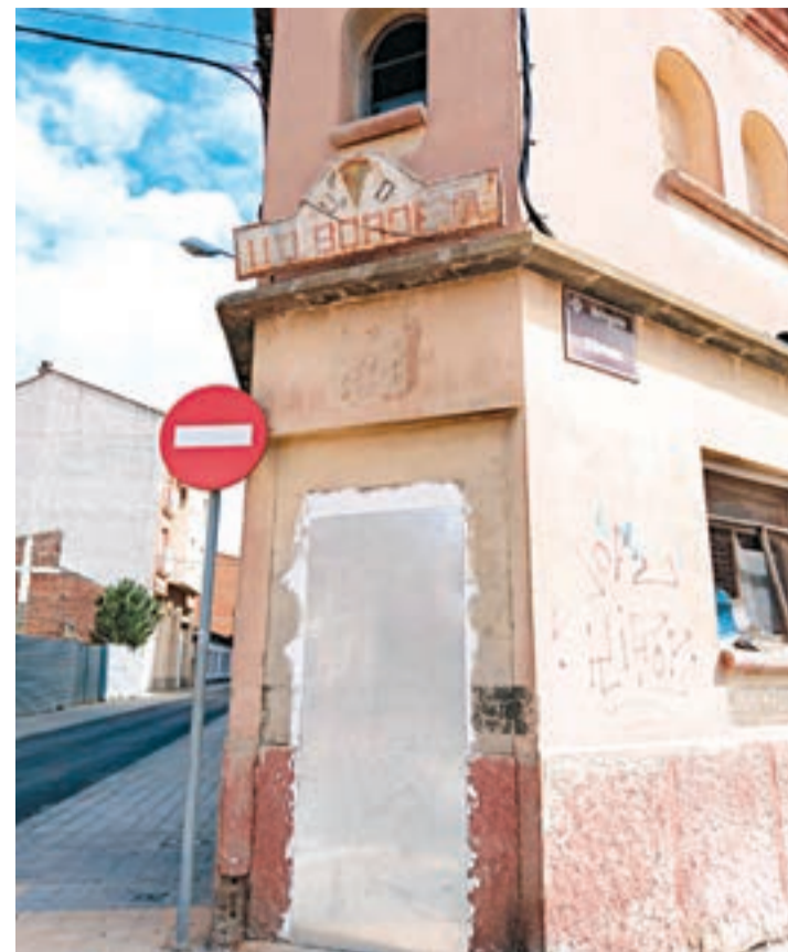
FOTO_ D.A. La porta instal·lada a l'immoble
