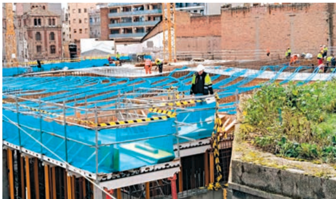
FOTO_ D.A. Tècnics i treballadors sobre la nova estructura de l'equipament
