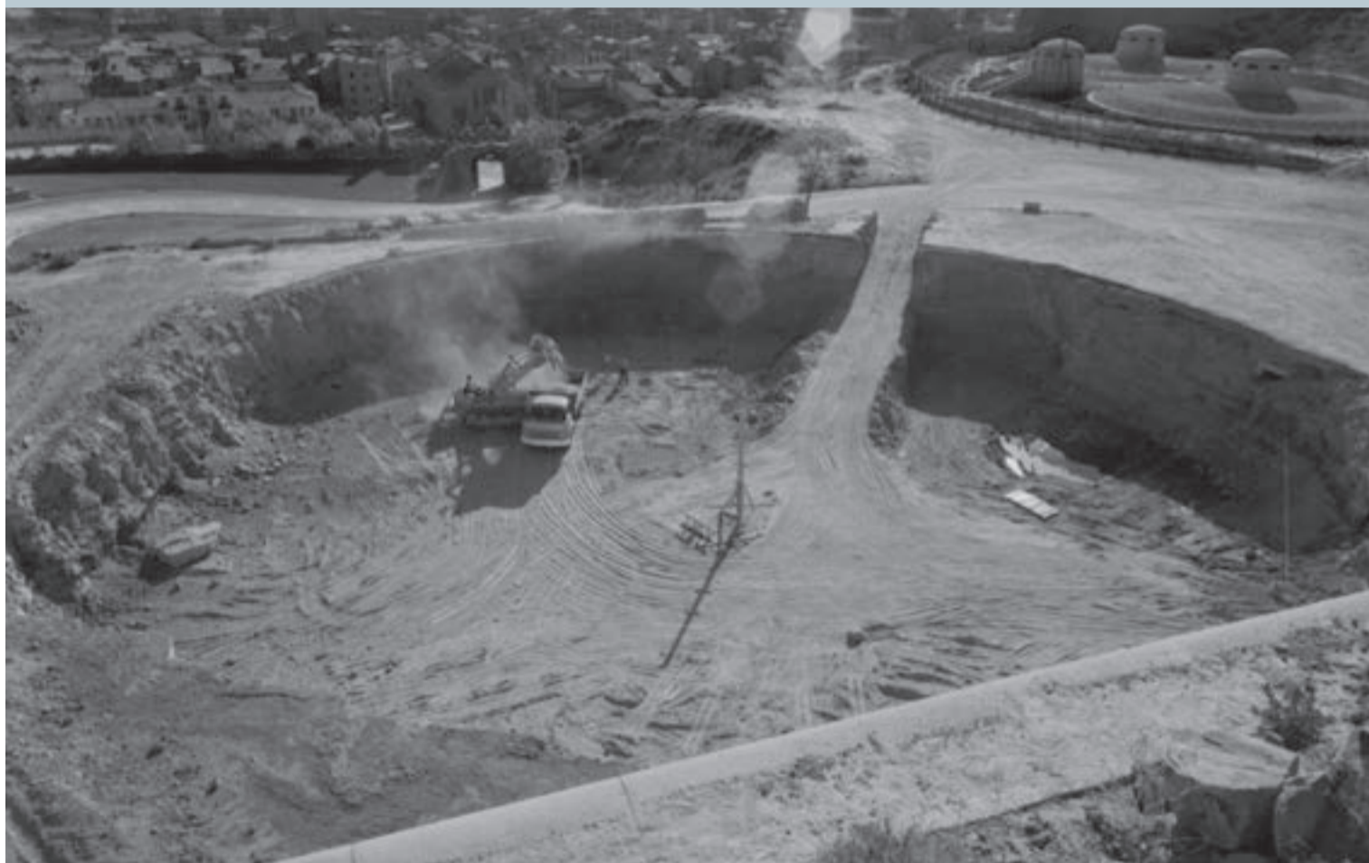
Una imatge de la construcció del dipòsit d'aigua a la Plaça de la Sardana. Fons Gómez Vidal (sense datar)
