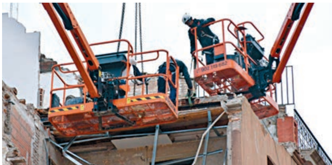
FOTO_ Irene Nyemeck Treballadors en dues grues durant les actuacions a l'habitatge
