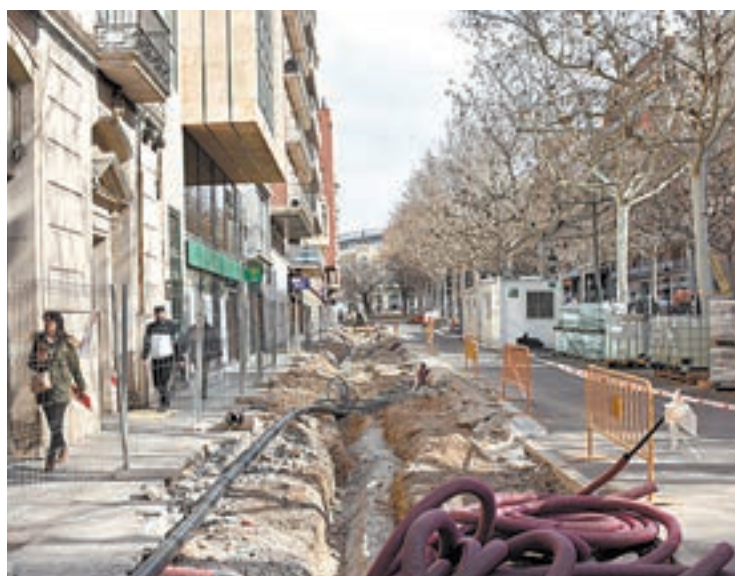
FOTO_ Irene Nyemeck Estat actual de les obres
