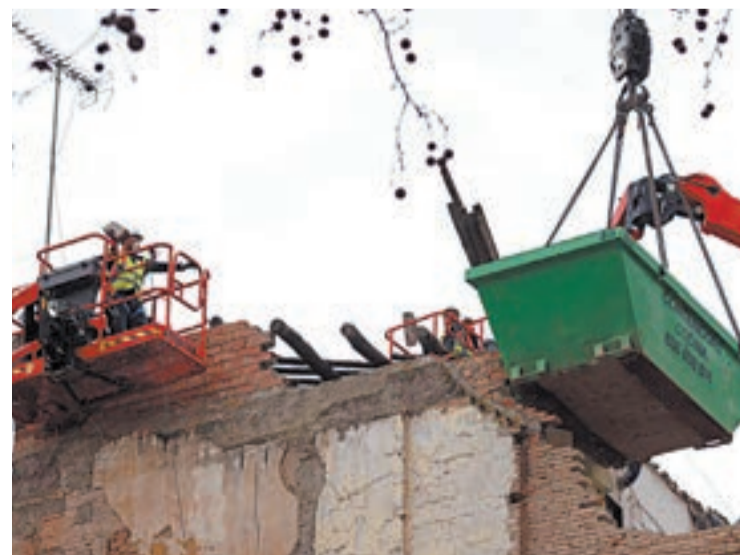
FOTO_ Tony Alcántara Operaris al sostre de l'edifici
