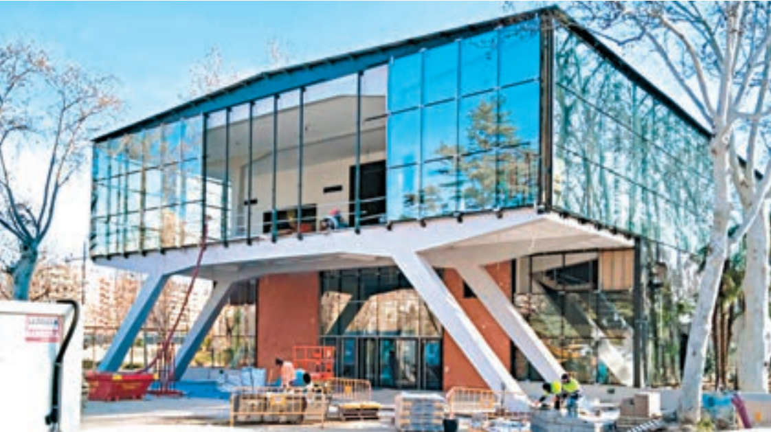
FOTO_ D.A. Els treballs de reforma de l'emblemàtic edifici estan molt avançats
