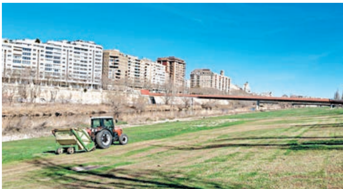
FOTO_ Paeria Tractor amb escarificadora al marge esquerre de la canalització del riu Segre
