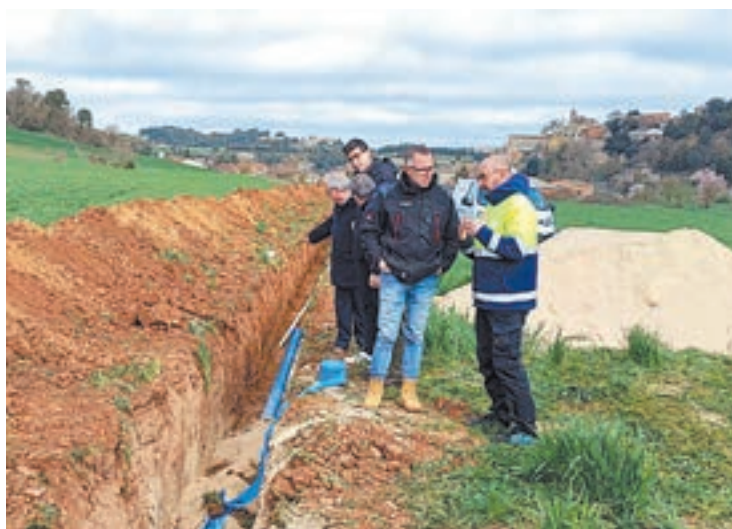
FOTO_ CCS El president del Consell de la Segarra durant la visita a les obres
