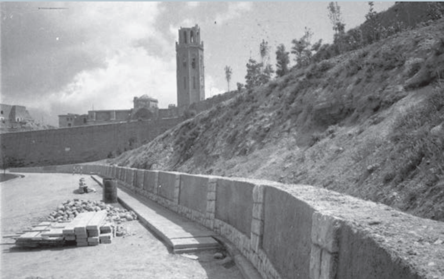
Construcció del mur de contenció dels jardins sota la muralla de la Llengua de Serp. Fons Gómez Vidal (sense datar)
