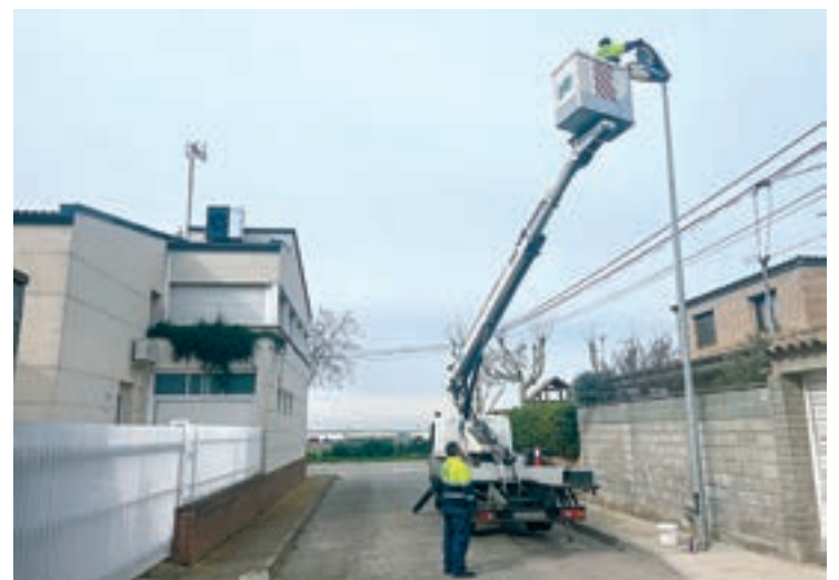
FOTO_Aj. Tàrraga Operaris treballant al barri de Fàtima
