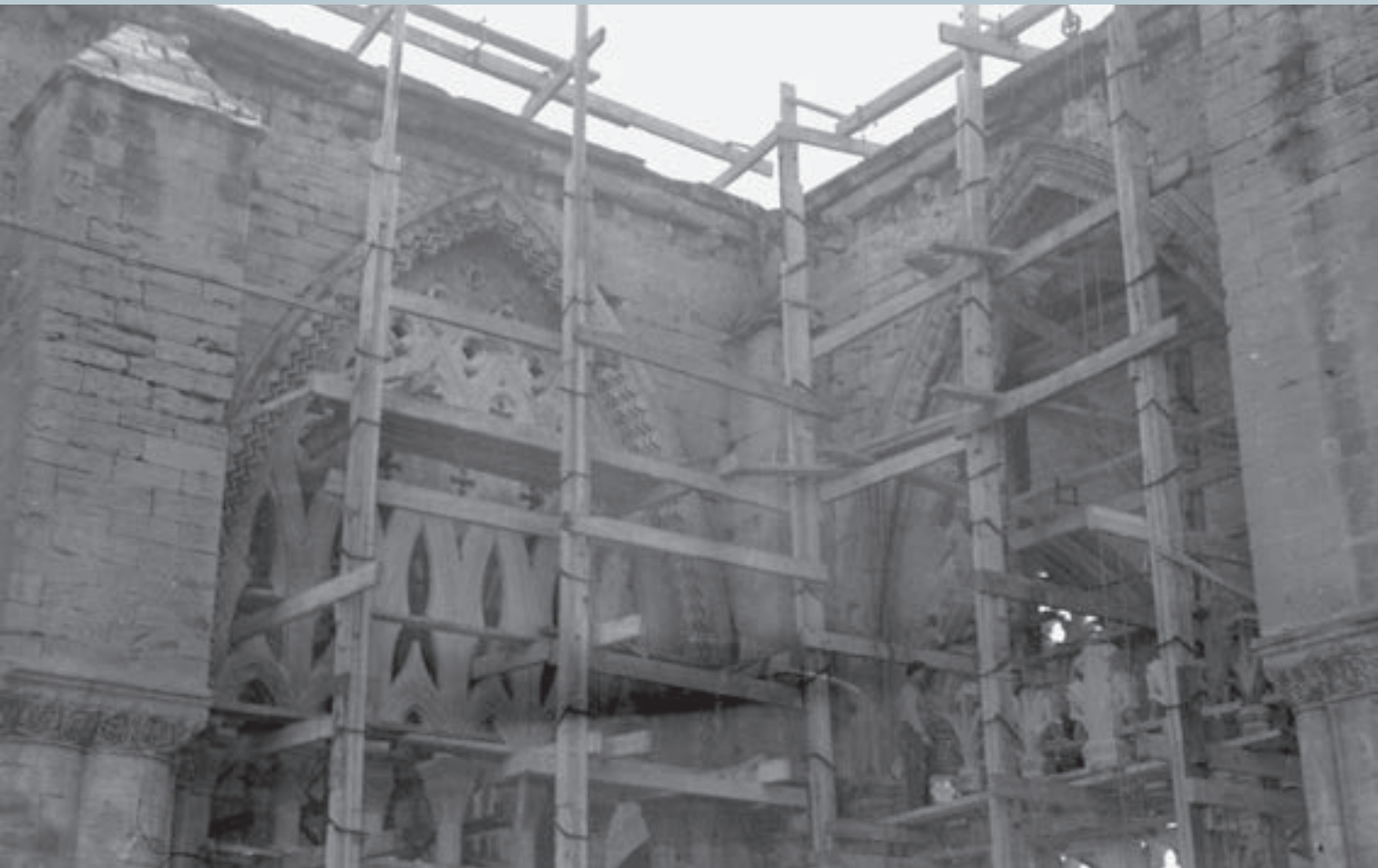
Una imatge d'unes obres de restauració al claustre de la Seu Vella. Fons Gómez Vidal (sense datar)
