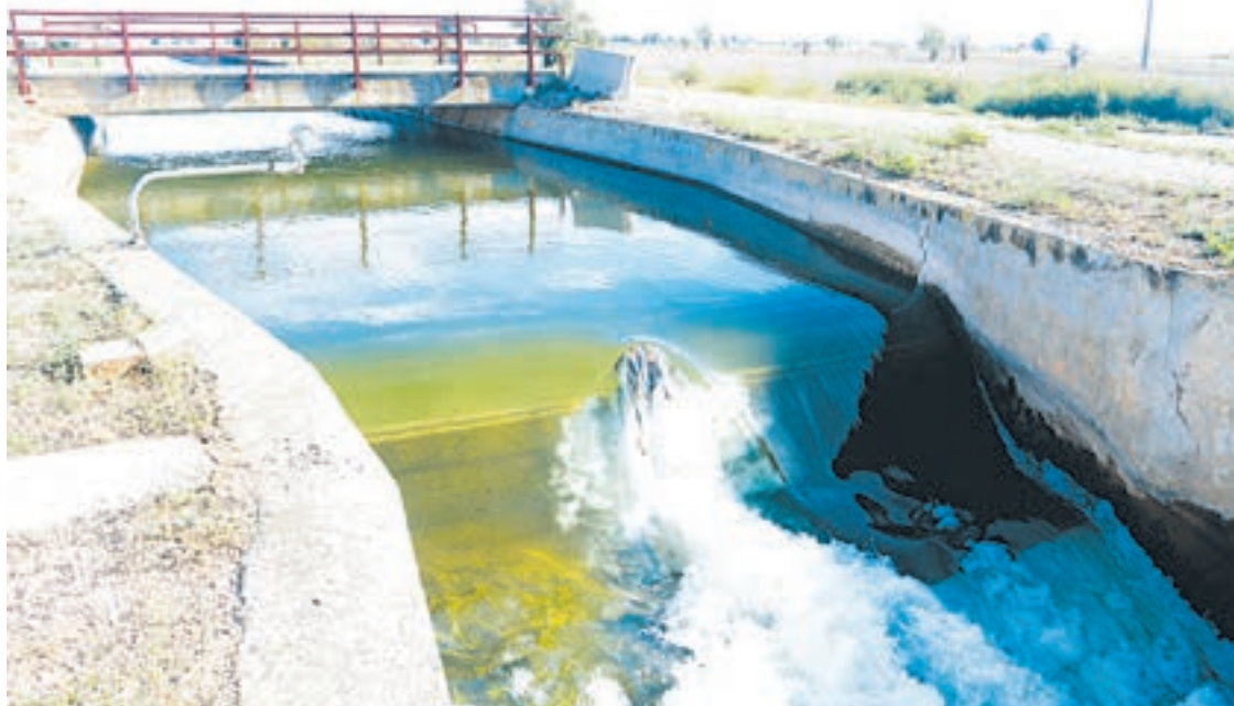
FOTO_ACN El Canal d'Urgell amb aigua circulant entre Vilanova de Bellpuig i Arbeca
