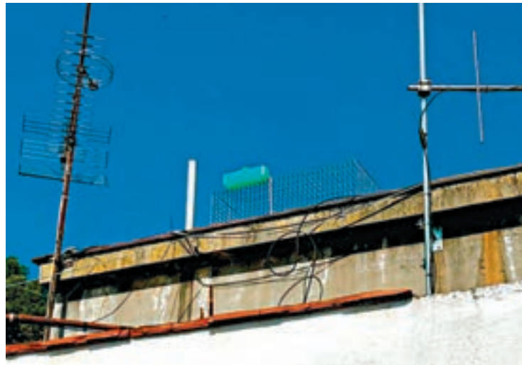
FOTO_ Paeria Una de les gàbies ja instal·lada
