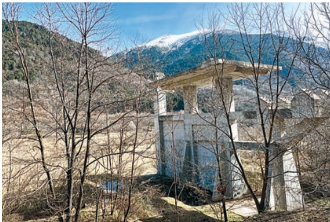
FOTO_ACN Una infraestructura de formigó en un terreny adquirit per la Torre de Cabdella
