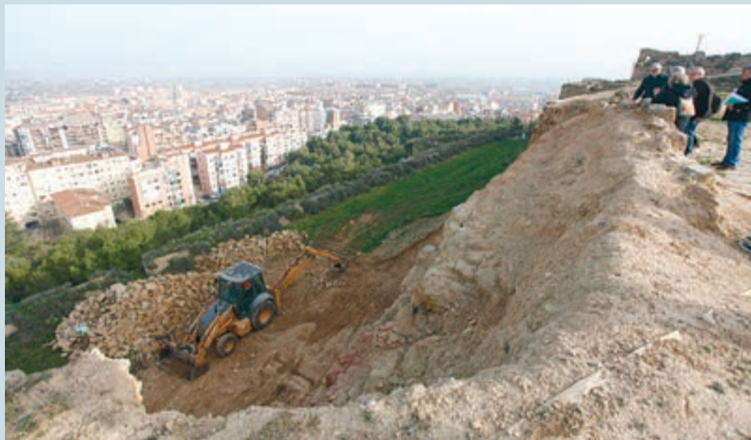
FOTO_Tony Alcántara L'alcalde ha visitat les obres al Baluard del Rei
