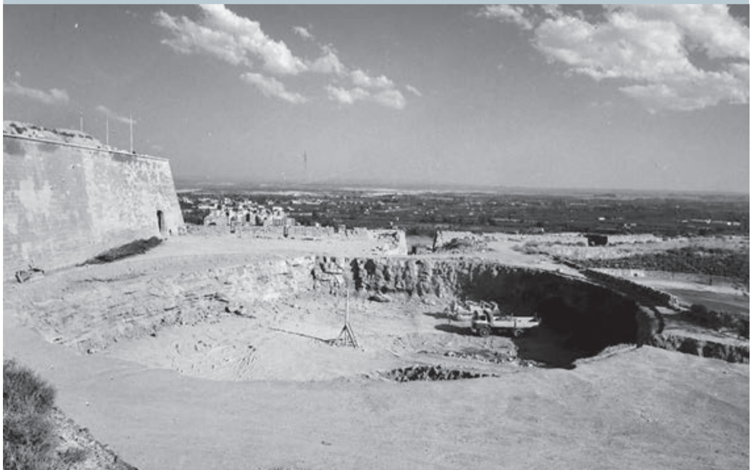
Imatge de les obres de construcció del dipòsit d'aigua a la Plaça de la Sardana. Fons Gómez Vidal (sense datar)
