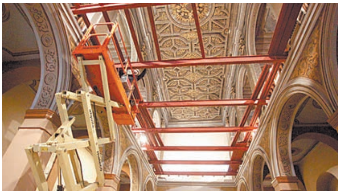
FOTO_ Tony Alcántara Un operari amb la grua a l'interior de l'església
