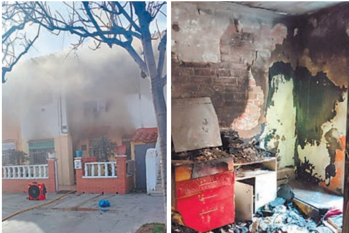
FOTO_ L.M. La casa unifamiliar del carrer Verge dels Desamparats va patir greus danys
