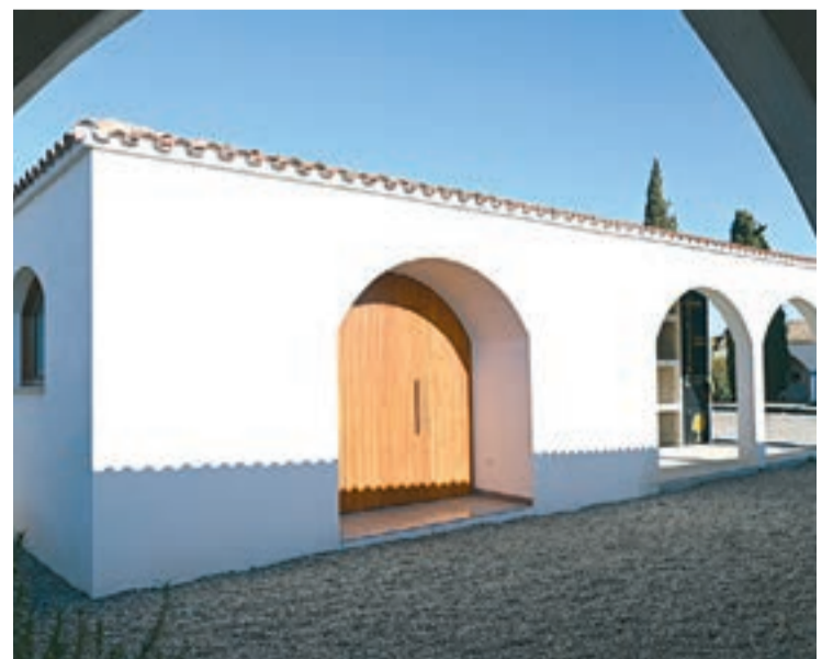
FOTO_ Núria García L'edifici, situat al cementiri
