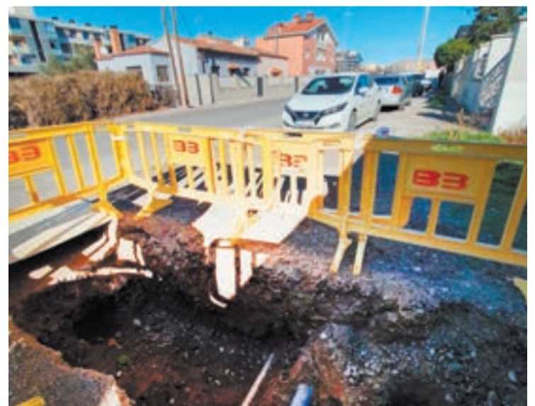
FOTO_ La Paeria Les obres a l'avinguda Flix
