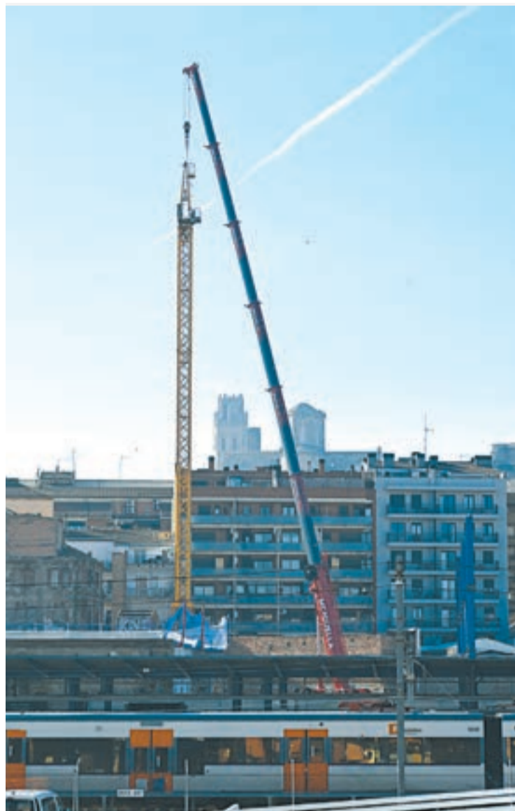
FOTO_ N. García Tasques d'instal·lació de la grua
