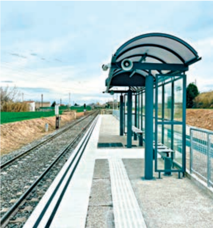
FOTO_ RafapMedina Les obres del baixador ja estan gairebé enllestides després de quatre mesos de treball
