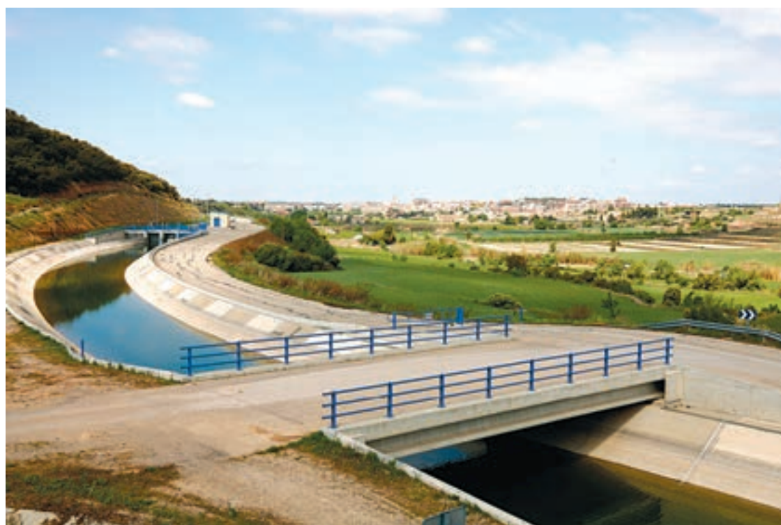
FOTO_ACN Un dels trams del Canal Segarra-Garrigues a l'alçada del Talladell
