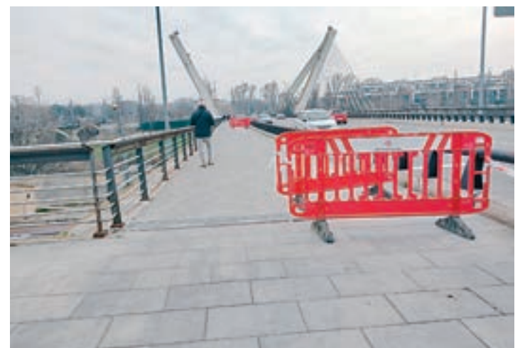
FOTO_ D.A. Tanques instal·lades a la vorera del pont
