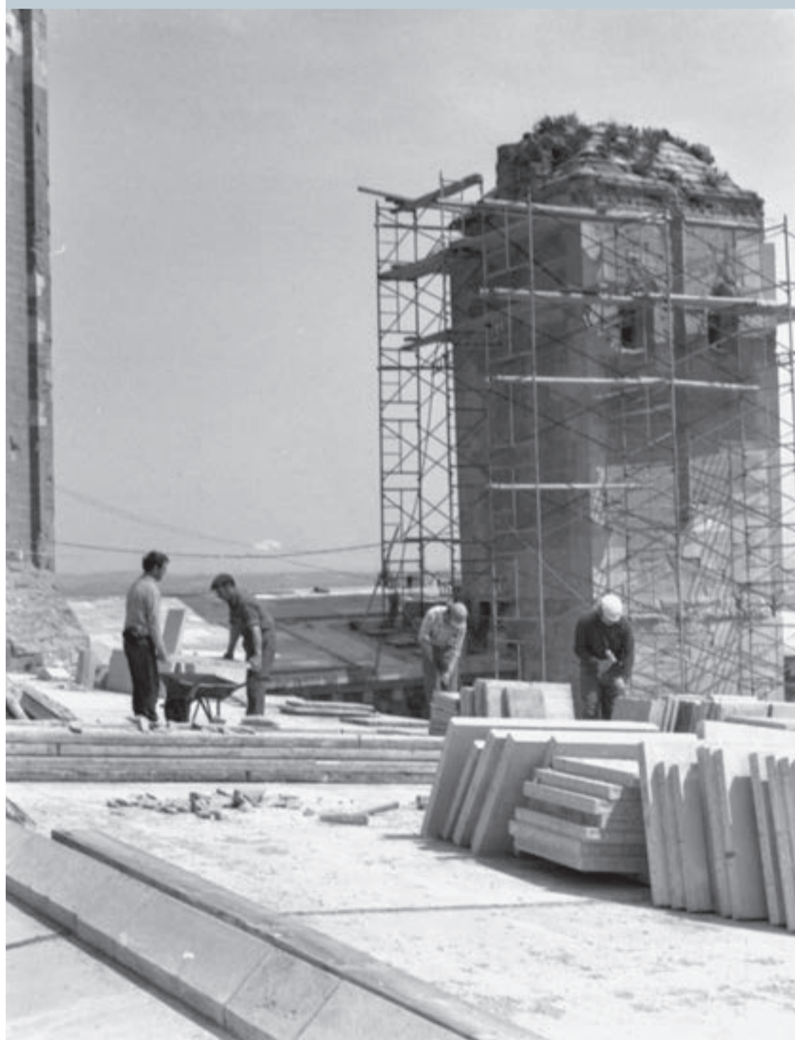
Obres de reconstrucció de la Torre dels Exorcismes. Fons Gómez Vidal (sense datar)
