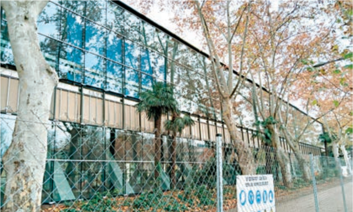
FOTO_ D.A. L’edifici ja llueix bona part de la façana amb els nous vidres
