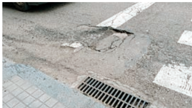
FOTO_ D.A. Forat al paviment a la cruïlla amb Prat de la Riba
