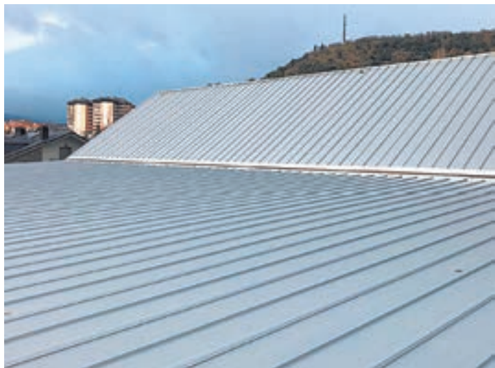
FOTO_ Aj. Seu Imatge de la nova coberta instal·lada
