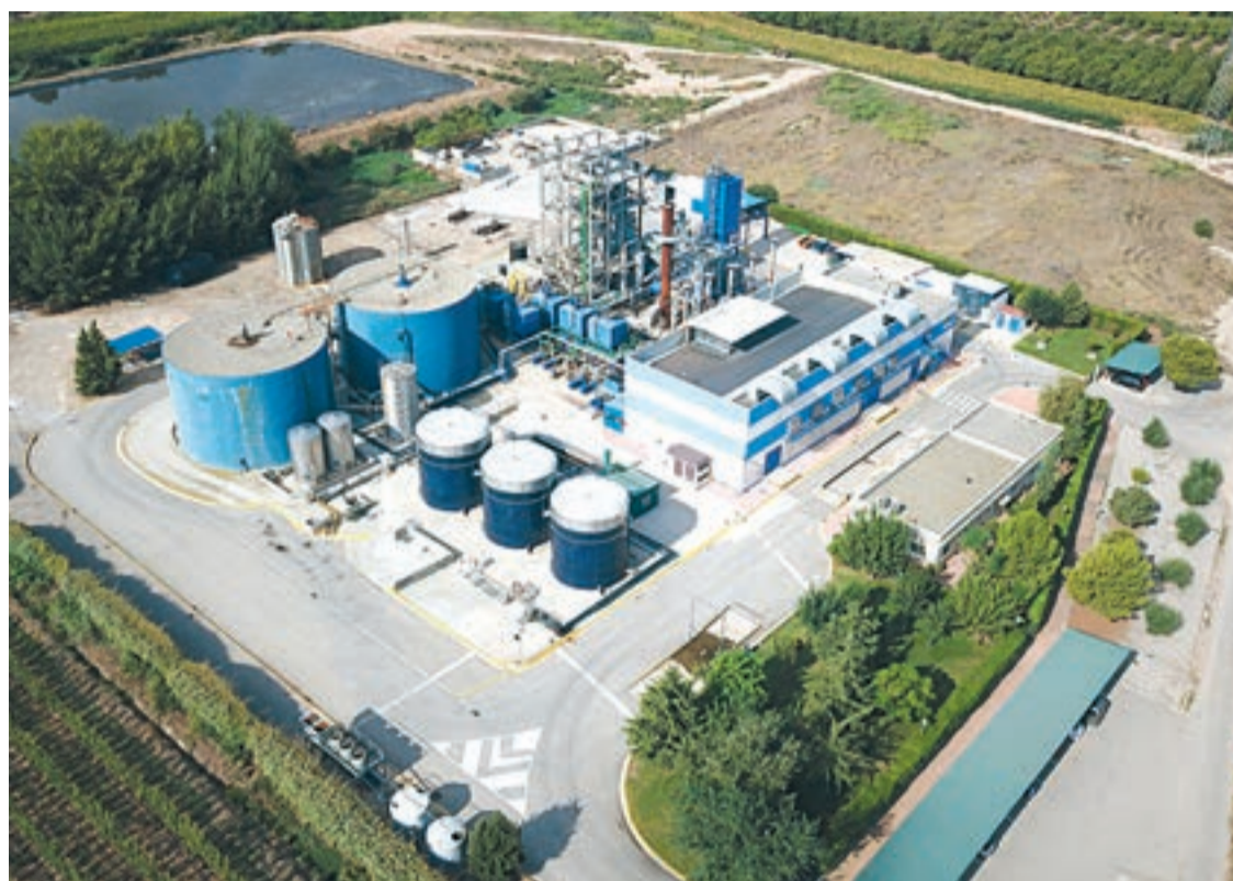
FOTO_ GAP Cooperativa Imatge de la planta de dejeccions ramaderes Tracjusa 2
