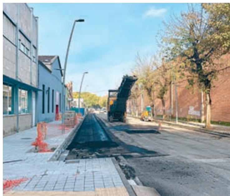
FOTO_RafaPMedina Maquinària ficant el nou paviment
