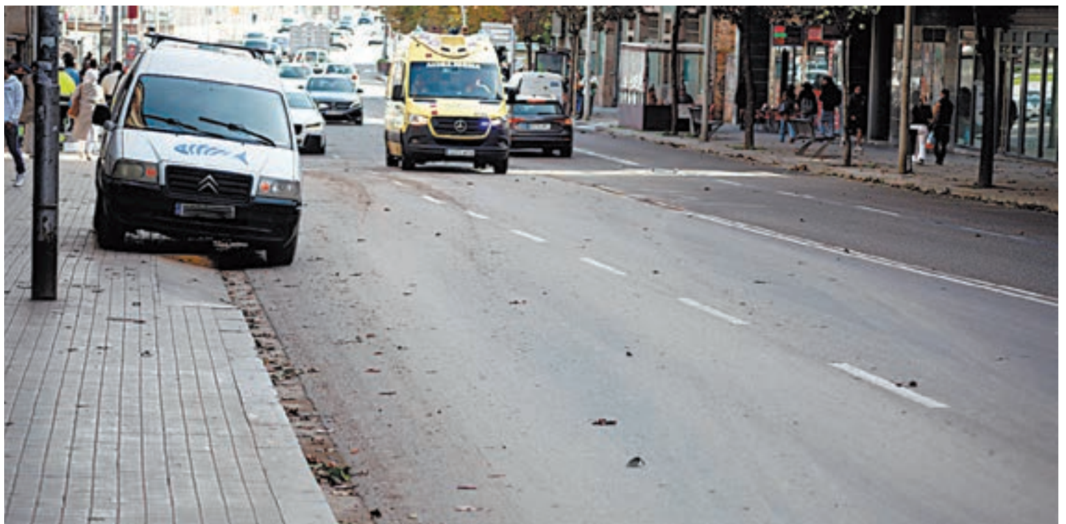
FOTO_Tony Alcántara El pas de cotxes i camions aixeca una polseguera important arran de les obres de l'estació
