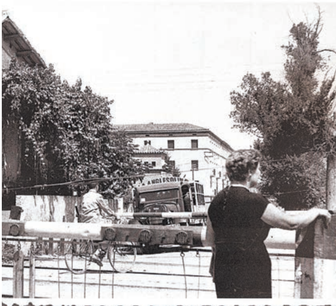
El pas a nivell de Balàfia era un dels més perillosos de la ciutat. Foto Lluís Terrés.
