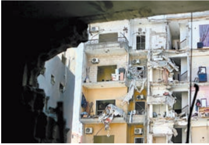
FOTO_EFE Imatge d'un edifici amb danys causat per un atac israelí
