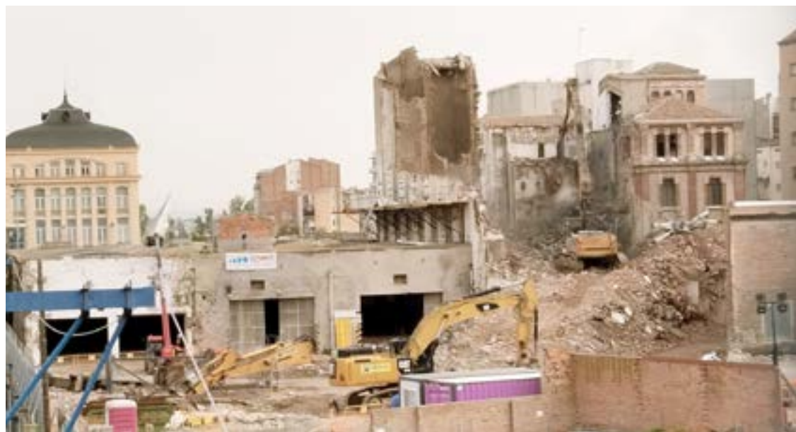
FOTO_ D.A. Una màquina demoleix els edificis annexos a la farinera La Meta
