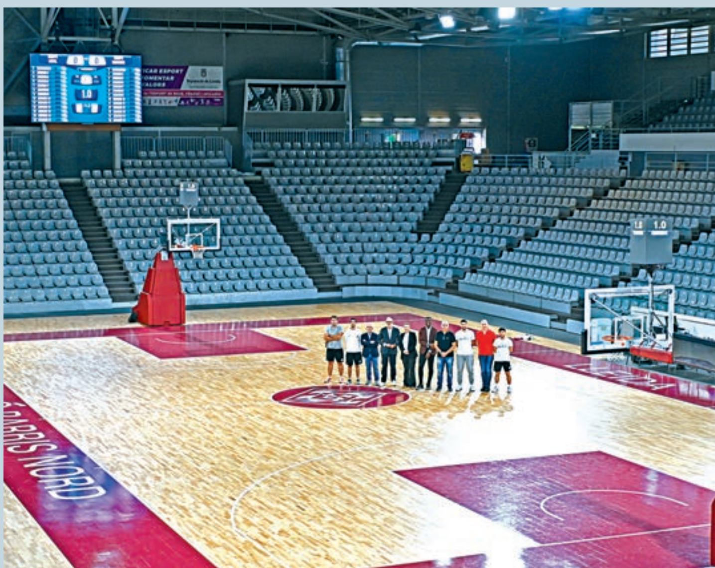
FOTO_Núria Garcia Autoritats, tècnics i directius van comprovar l'estat del pavelló
