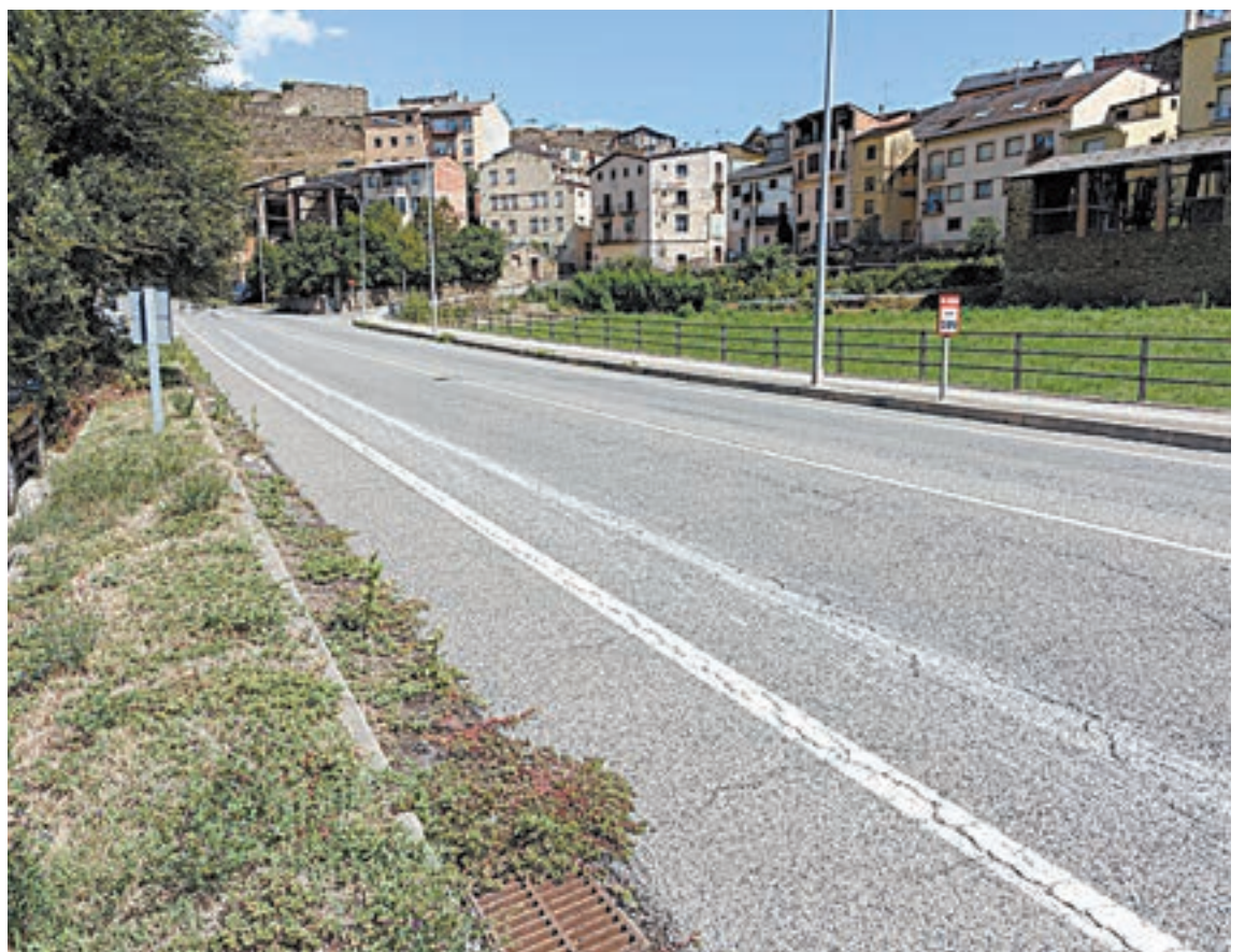
FOTO_ Aj.la Seu d'Urgell Imatge del tram de l'Eix Pirinenc on es construirà el pas
