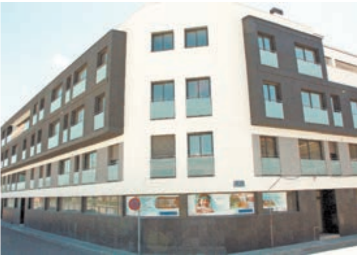
FOTO_ACN Imatge d'arxiu d'una promoció d'obra nova
