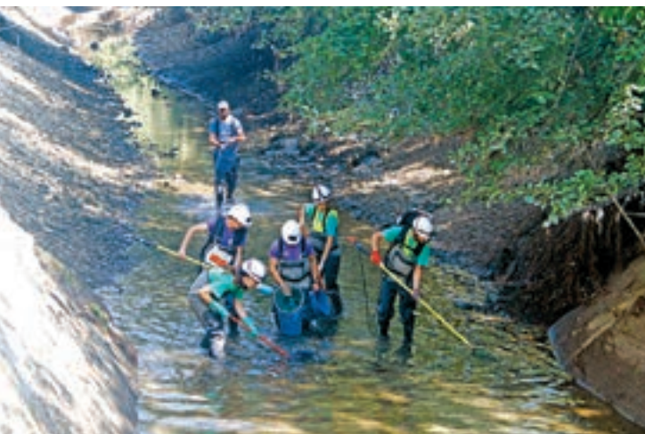
FOTO_Oriol Bosch (ACN) Tècnics treballant al canal
