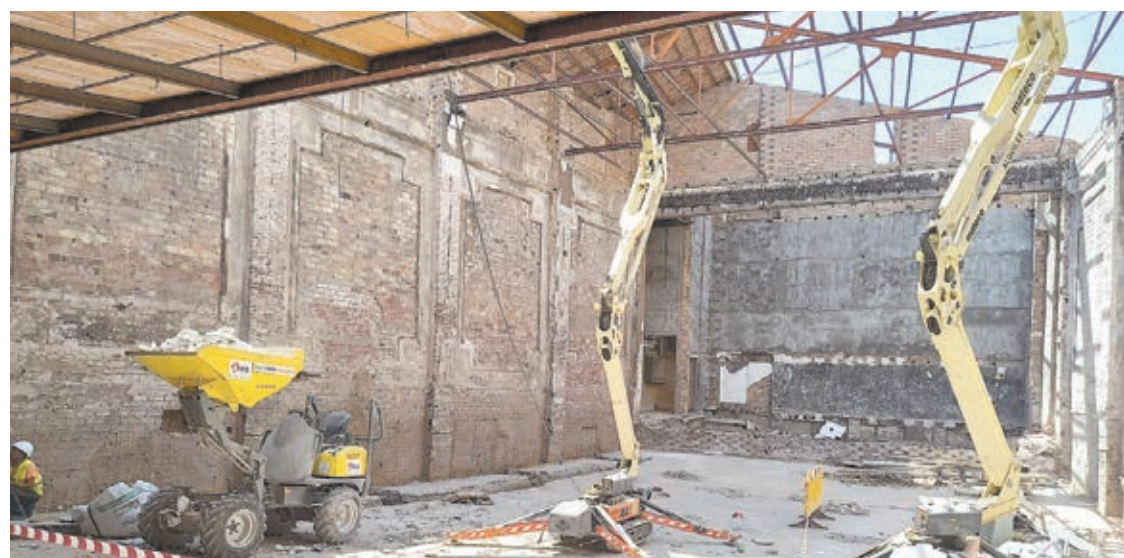
FOTO_ Aj. Fraga Imatge de les obres que s'estan duent a terme en aquest espai de Fraga
