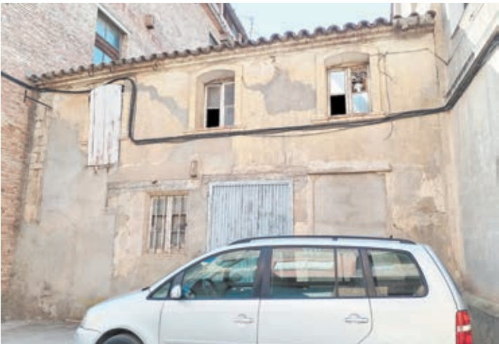
FOTO_ Tony Imatge d'un dels edificis en què s'haurà d'actuar en aquest projecte
