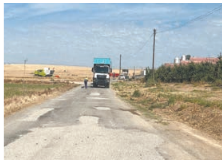
FOTO_ Aj. Torrefarrera Operaris realitzant les obres de manteniment i millora a un dels camins escollits
