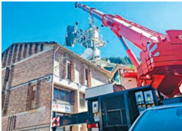
FOTO_ Aj. Pont de Suert Una grua treballant per retirar els elements malmesos de la torre de telefonia
