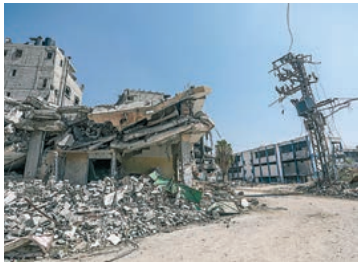
FOTO_ EFE Edificis enderrocats al centre de Gaza
