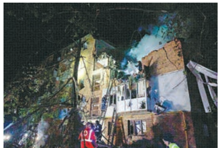
FOTO_EPA Edifici destruït a Khàrkiv per bombes russes
