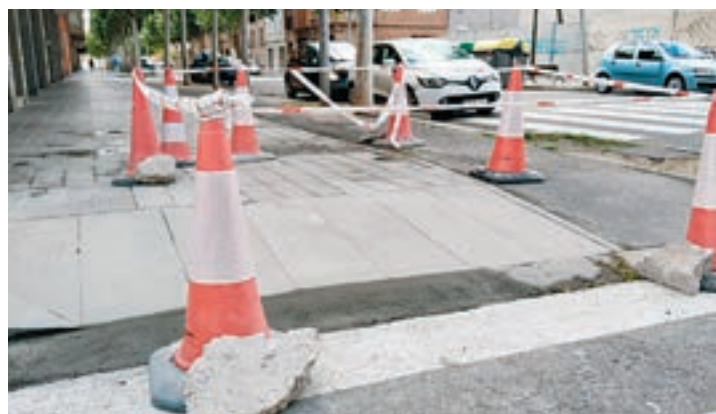
FOTO_ D.A. Cons per senyalitzar la zona en obres
