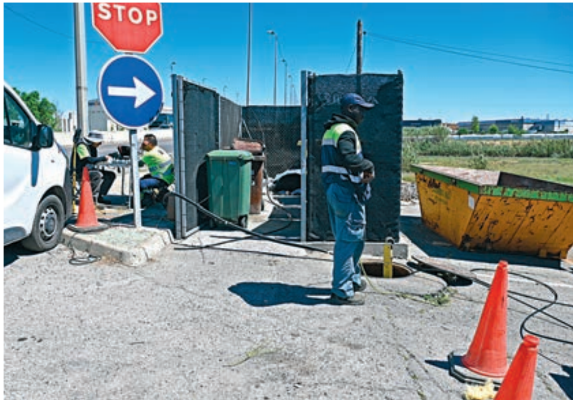
FOTO_ Núria García Moment en què ahir els tècnics treballaven en la reparació
