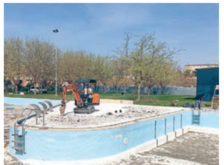
FOTO_ L.M. Els treballs de millora a les piscines d'estiu
