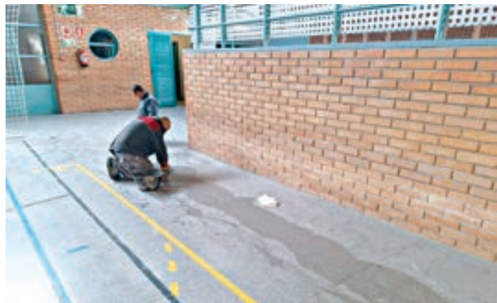
FOTO_ Paeria de Lleida Imatge de les reparacions
