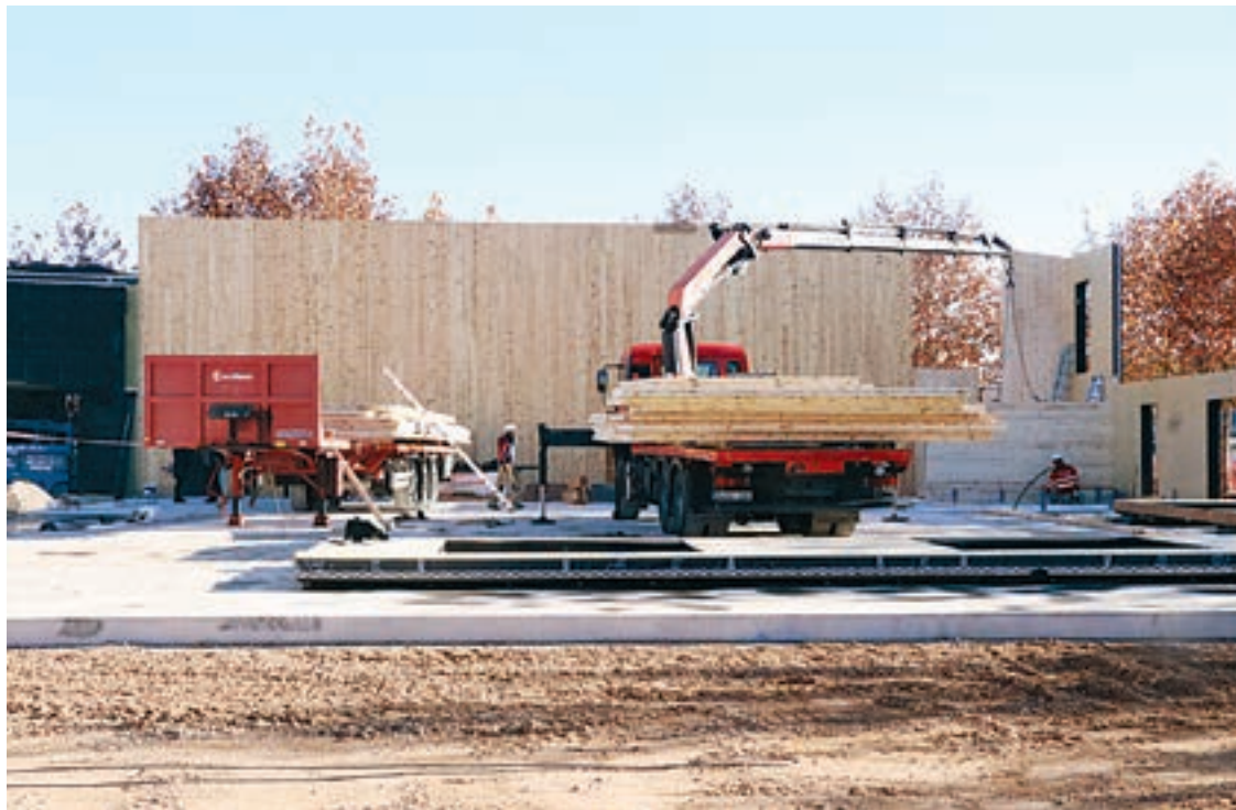
FOTO_ACN Imatge de la construcció de l'equipament a Olius
